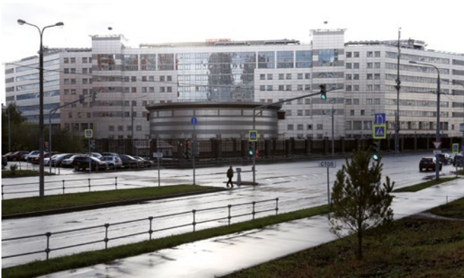
Gebäude des GRU
